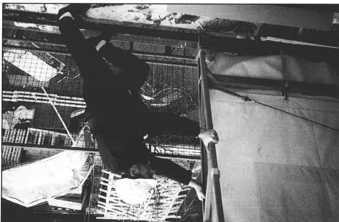
Foto 4: Rullbart takskal för produktionsmiljöer vid takarbeten.
