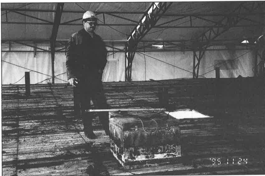
Foto 3: Det väderkänsliga takbjälklaget exponeras för vädrerpåverkan vid demontage av det gamla taket.
